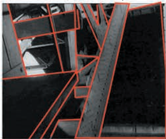
Structure du dessous du pont.
